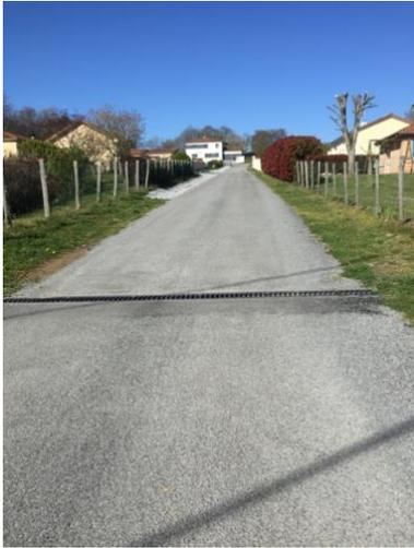
Talutage sur la **route du puits**, élargissement de celle-ci avec empierrement et revêtement.
