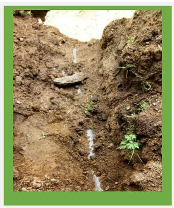
Suite à une obstruction de la canalisation des eaux usées du bâtiment du relais multi-services, la réfection de cette évacuation a été nécessaire. Les travaux ont été confiés à l'entreprise Marecchia. Pour compléter cet aménagement, le drainage des eaux pluviales tout autour du bâtiment communal a été effectué.
