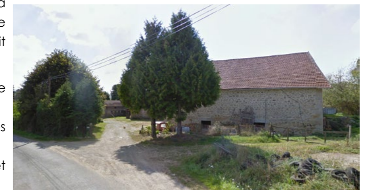
Ferme à bâtiments dissociés à la Tronchère.
