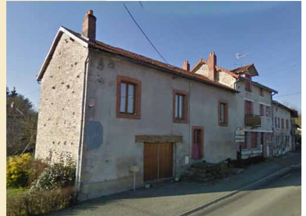
Maisons de village accolées au Chatenet (Saint-Denis-des-Murs).
