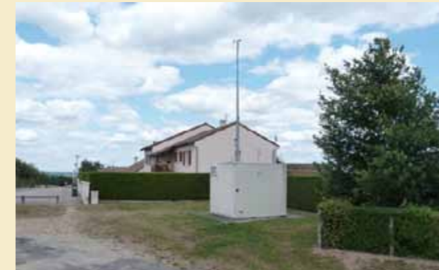
Station périurbaine de fond de Garros (Palais-sur-Vienne)
