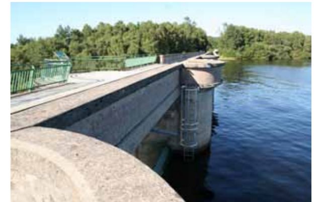
Barrage du lac de Vassivière
