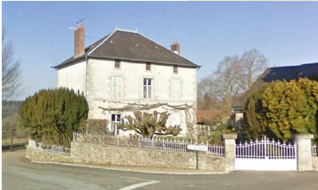
Maison bourgeoise dans le bourg de Saint-Denis-des-Murs, couverture en ardoise moins répandue..
