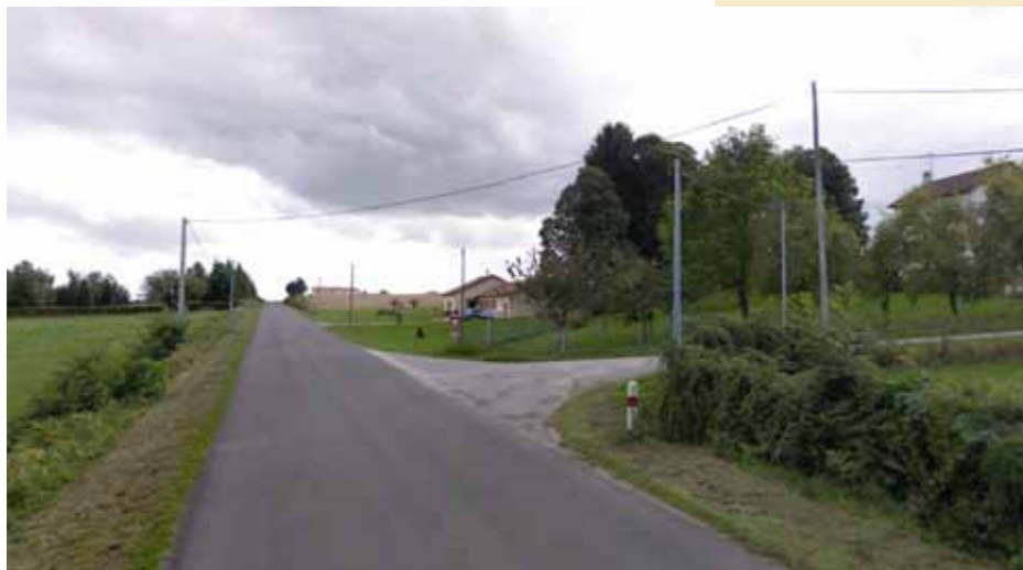
Renforcement électrique dans le secteur de la Garde (Eybouleuf) pour faire face à la pression foncière : implantation d'un important transformateur.
