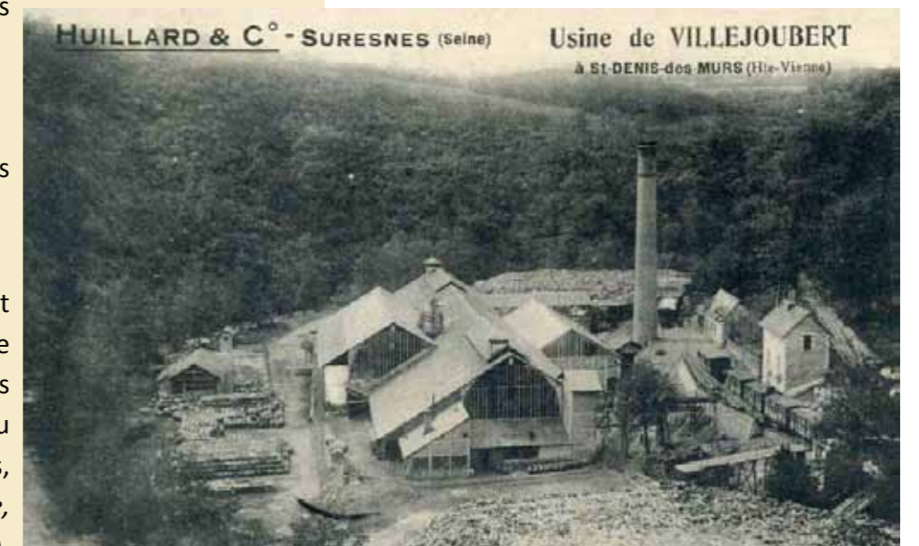
Au lieu-dit « L'Usine », au bord de la Vienne, l'usine Huillards produisait jusqu'en 1953 des extraits tannants des châtaigniers (Source : bulletin municipal, 09.2010, Saint-Denis-des-Murs).
