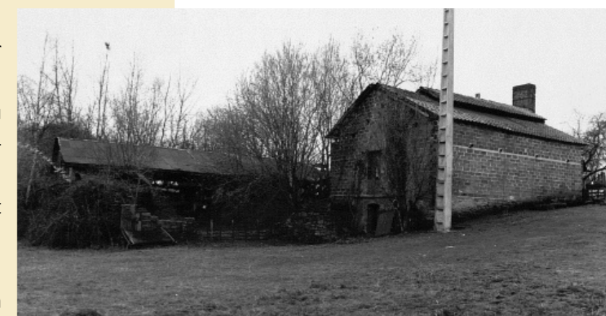
Ancienne tuilerie du Verdurier (Eybouleuf) : au premier plan four de cuisson, au second plan bâtiments de fabrication et de séchage (source : Région Limousin - Service de l'Inventaire et du Patrimoine culturel).
